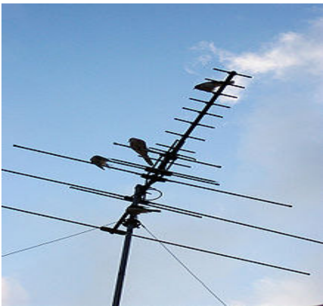
Esempio di antenna televisiva
